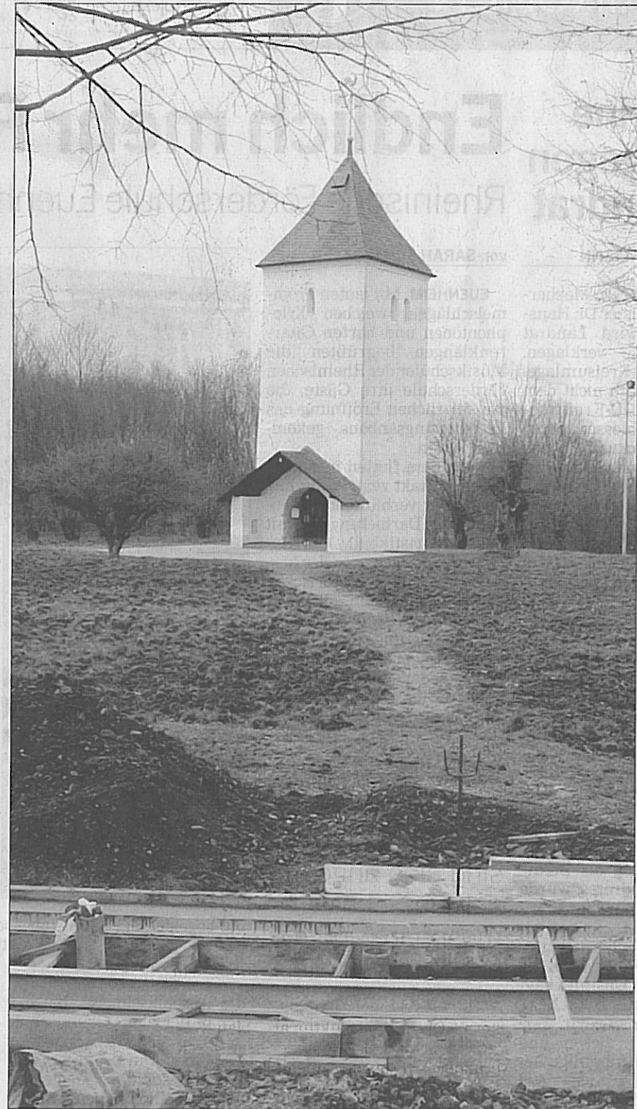
Der Swister Turm ist der Rest einer alten Kirche und beliebtes Ausflugsziel sowie ein Ziel für Pilger aus der gesamten Region. Weil hier die Wildschweine die Wiese umwühlen, muss jetzt ein fast 500 Meter langer Zaun um das Gelände gebaut werden. Im Vordergrund das Fundament für das Wildtrittgitter. (Foto: Zimmermann)
